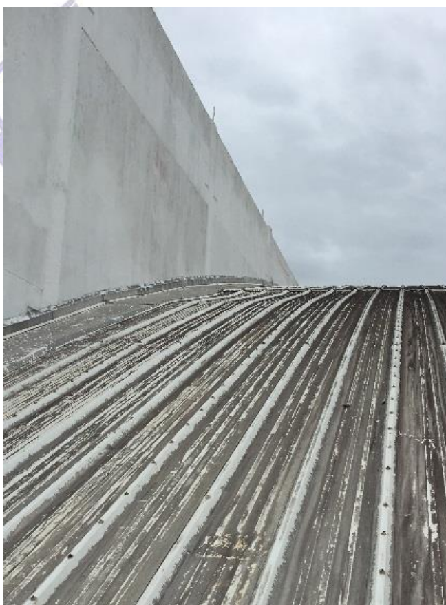
Figura 5: Telha termoacústica trapezoidal do pavilhão principal.
