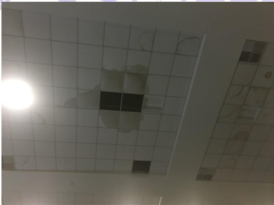
Figura 41: Muitas placas prejudicadas pelas continuas chuvas sem a devida proteção da cobertura.
