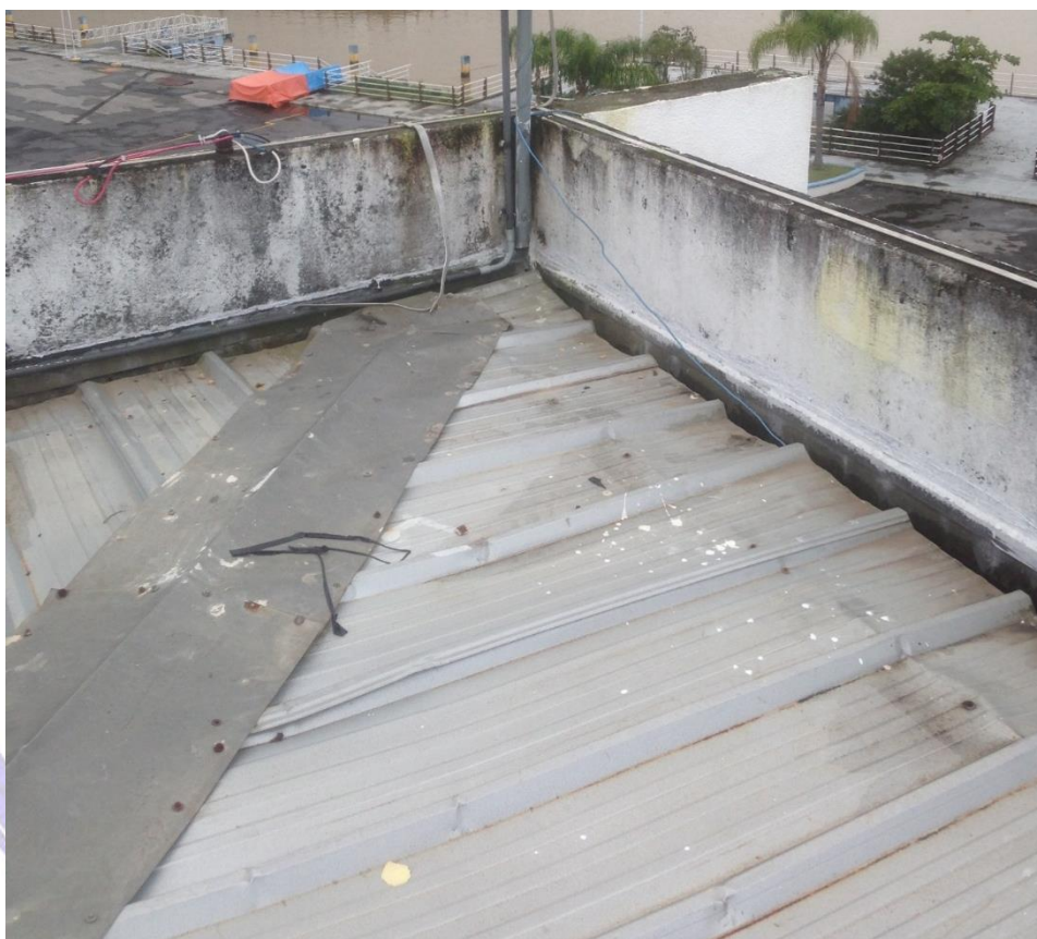
Figura 30: Cumeeiras sem o recorte adequado na área de cobertura do auditório.
