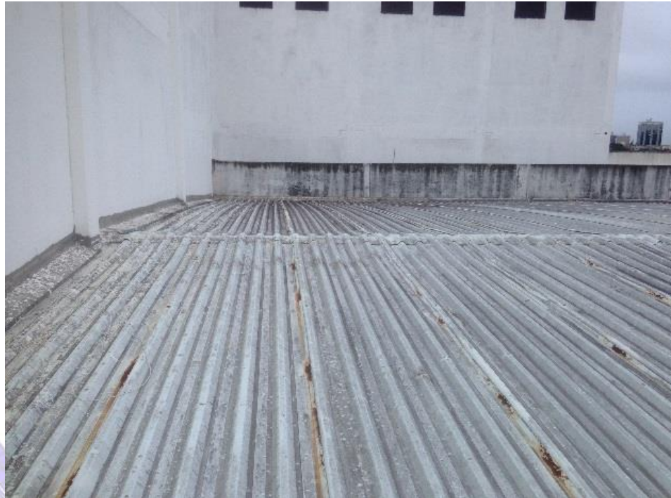
Figura 6: Telha termo acústica trapezoidal do pavilhão anexo.
