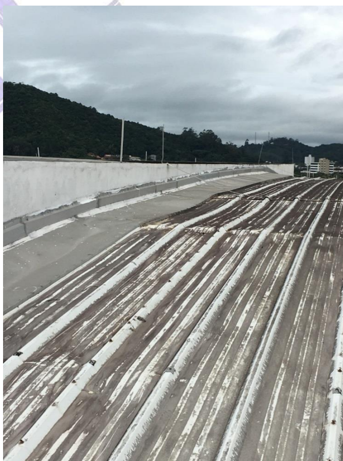
Figura 10: Telhas que sofreram deformações excessivas e possibilitam o acúmulo de água.
