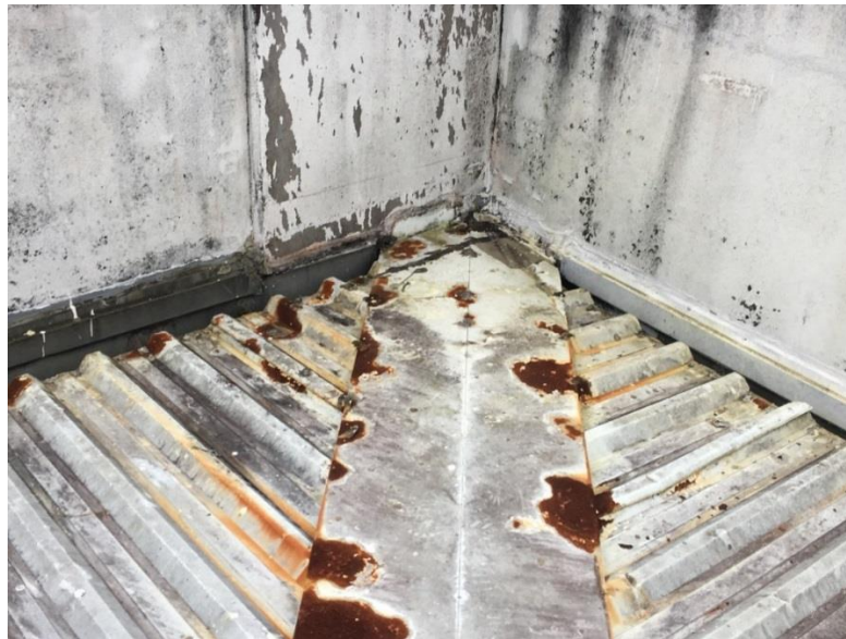
Figura 16: Cumeeiras sem o devido recorte, e com sinal de ferrugem adiantado.
