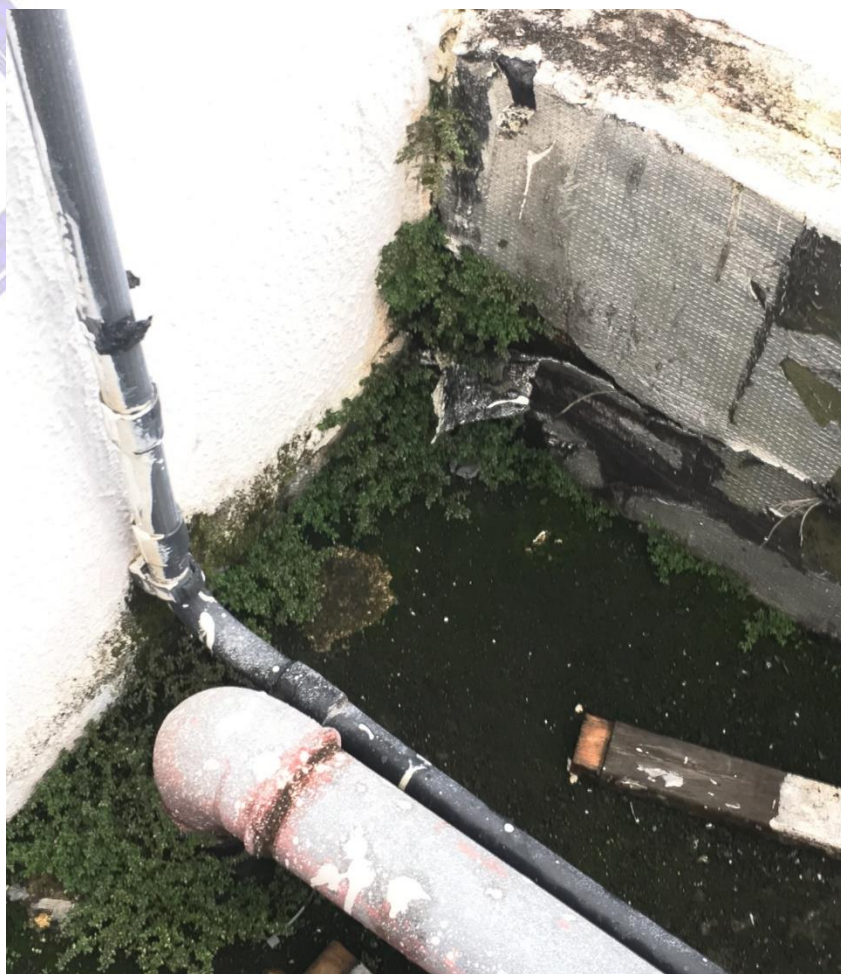
Figura 38: Plantas "brotando" devido ao tempo sem manutenção periódica adequada.
