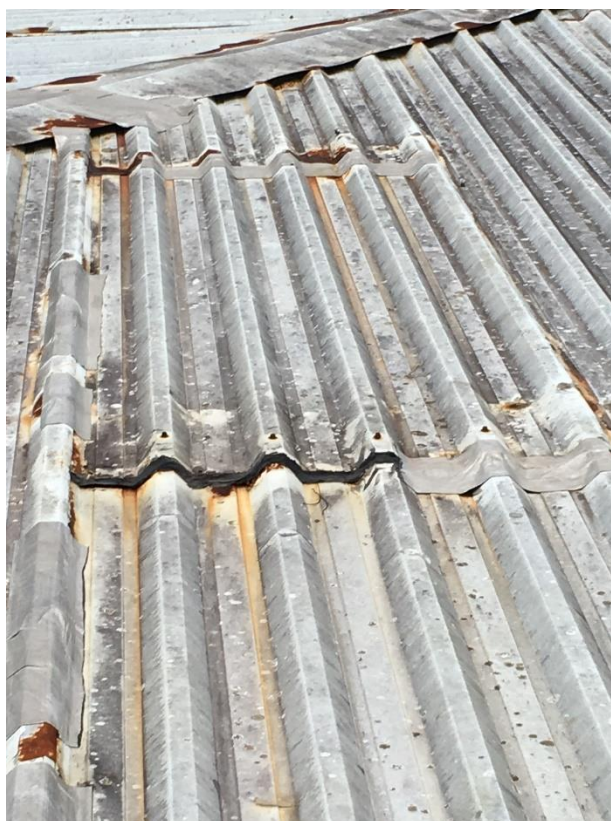
Figura 47: Tentativa de emenda se mostrando um método ineficaz.
