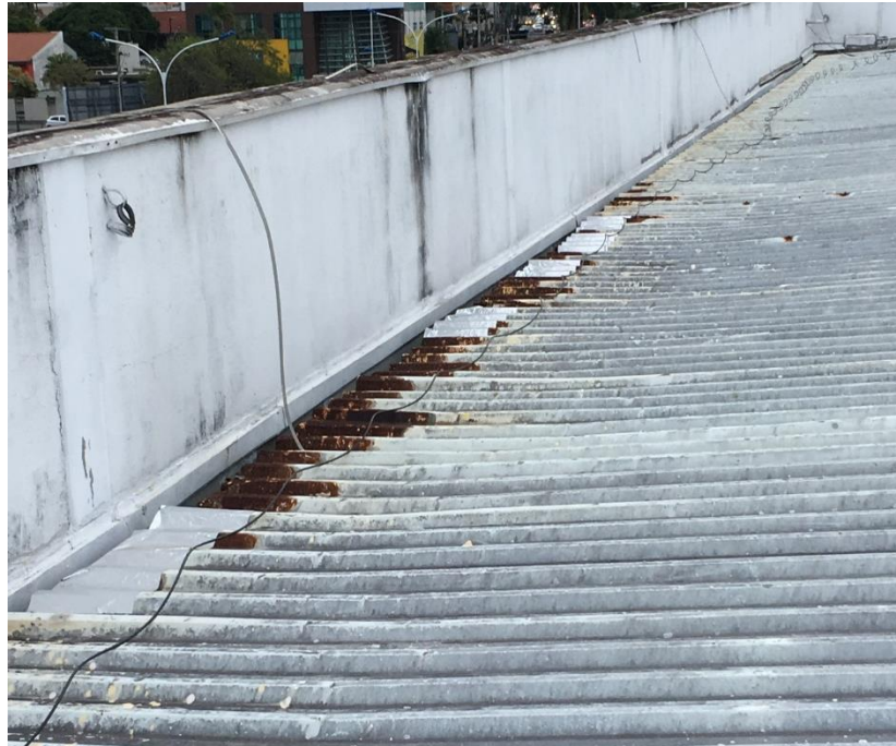
Figura 45: Alguns dos pontos que apresentam grande corrosão.
