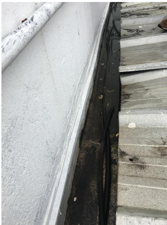
Figura 50: Tubulação indevidamente passada dentro da calha de recolhimento de água pluvial.
