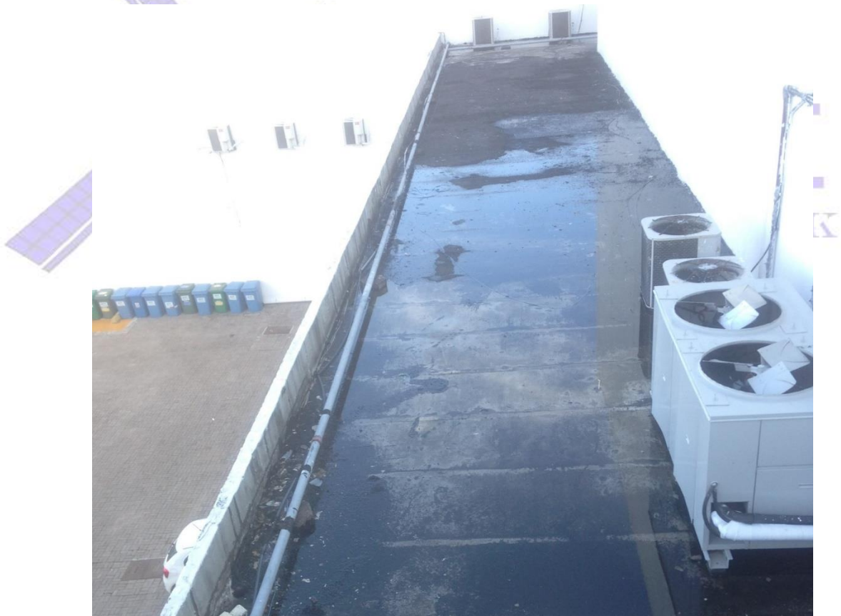
Figura 23: Laje da área técnica das máquinas de ar condicionado, manta asfáltica sem proteção mecânica e falta de caimento adequado para o ralo são as causas para o acúmulo de água. Foto de 16 de maio de 2019, 3 dias após chuva de média intensidade e como se pode observar, a água não havia escoado.
