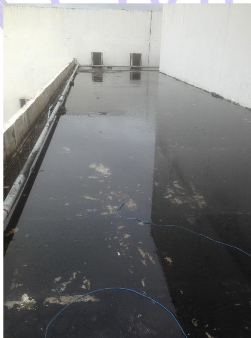
Figura 48: Falta de queda de água adequada ao contrapiso, ocasionam acúmulo de água.
