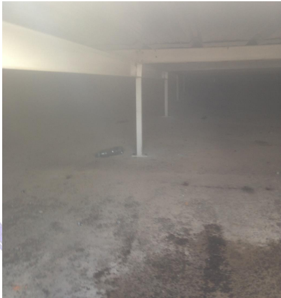
Figura 24: Estrutura metálica em bom estado onde não há acúmulo de água.
