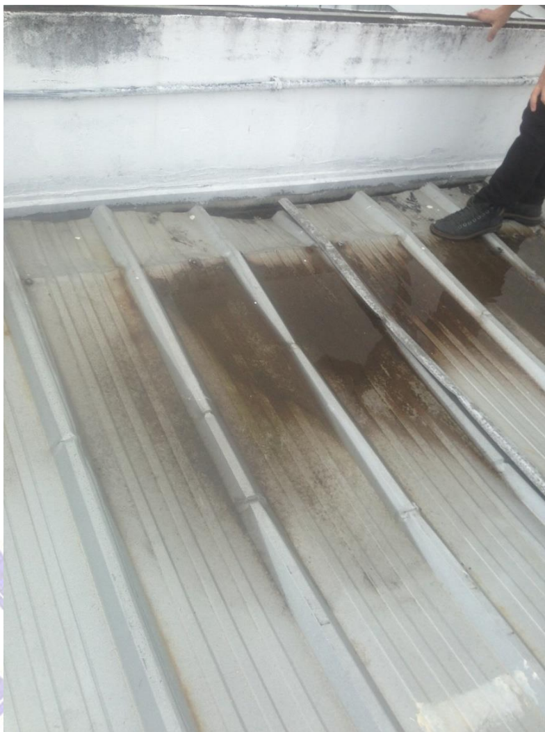
Figura 18: Muitas telhas amassadas devido ao trânsito indevido de pessoas.
