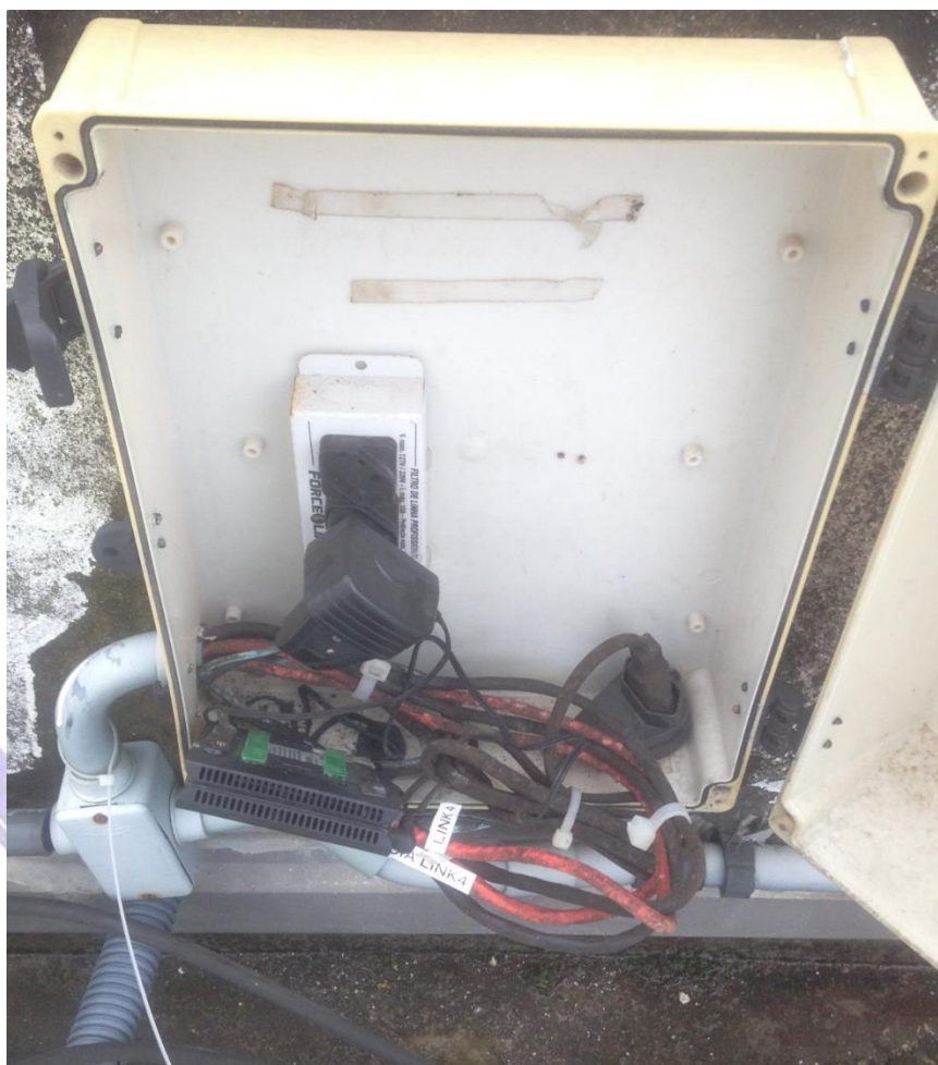
Figura 36: Equipamento de comunicação e fiação elétrica que deveria estar protegido.
