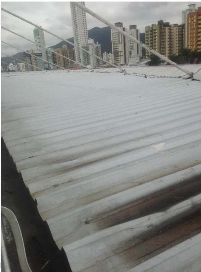
Figura 8: Telha trapezoidal simples da cobertura do detalhe da fachada frontal.
