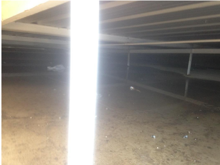
Figura 22: Visita feita em 16 de maio, 3 dias após chuva de média intensidade. A laje apresenta acúmulo de água proveniente das aberturas do telhado.
