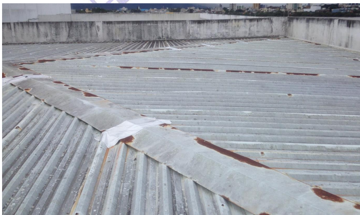
Figura 31: Cumeeiras sem o recorte adequado e em estado avançado de ferrugem, telhado anexo..
