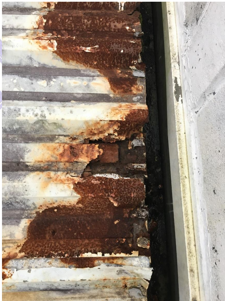
Figura 17: Em grande parte das telhas a ferrugem já atingiu a camada inferior.
