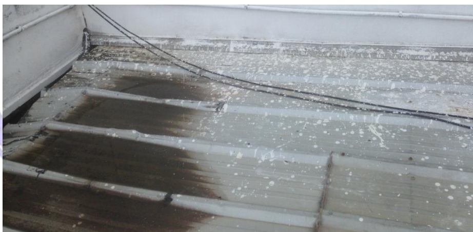
Figura 34: Cabos de comunicação, onde se vê também o acúmulo de água.
