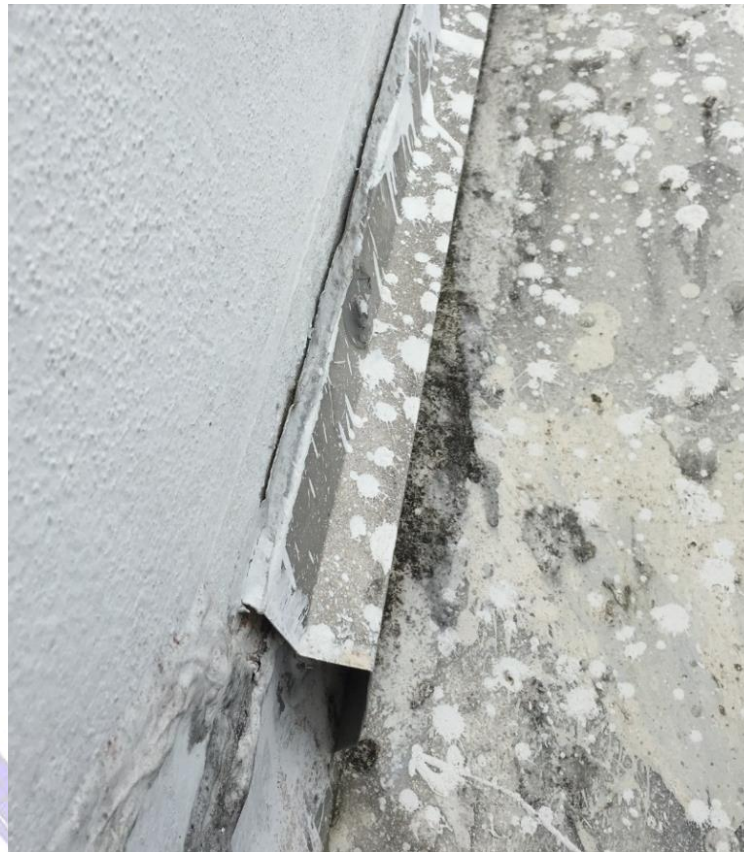
Figura 11: Rufos instalados com silicone PU, ineficaz para esse tipo de situação. Percolação de água entre a parte metálica e a parede.
