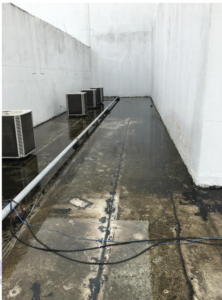
Figura 39: Lâmina da água por toda a laje técnica. Não há indícios de proteção mecânica.
