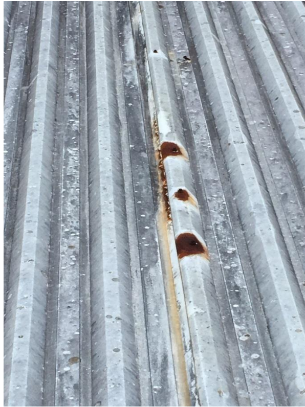
Figura 14: Grande parte dos parafusos apresenta ferrugem avançada que atingiu e espalhou para a folha.
