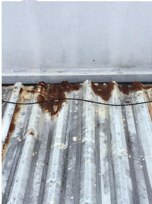
Figura 15: Pontas de telha expostas a ferrugem acelerada.
