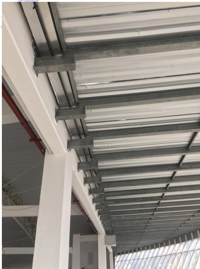
Figura 28: O telhado da fachada frontal já apresenta deformações que possibilitam infiltrações de água.
