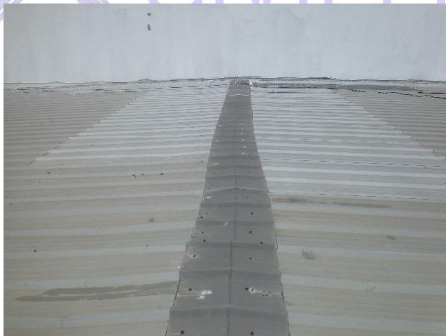
Figura 7: Telha trapezoidal simples da cobertura do auditório.
