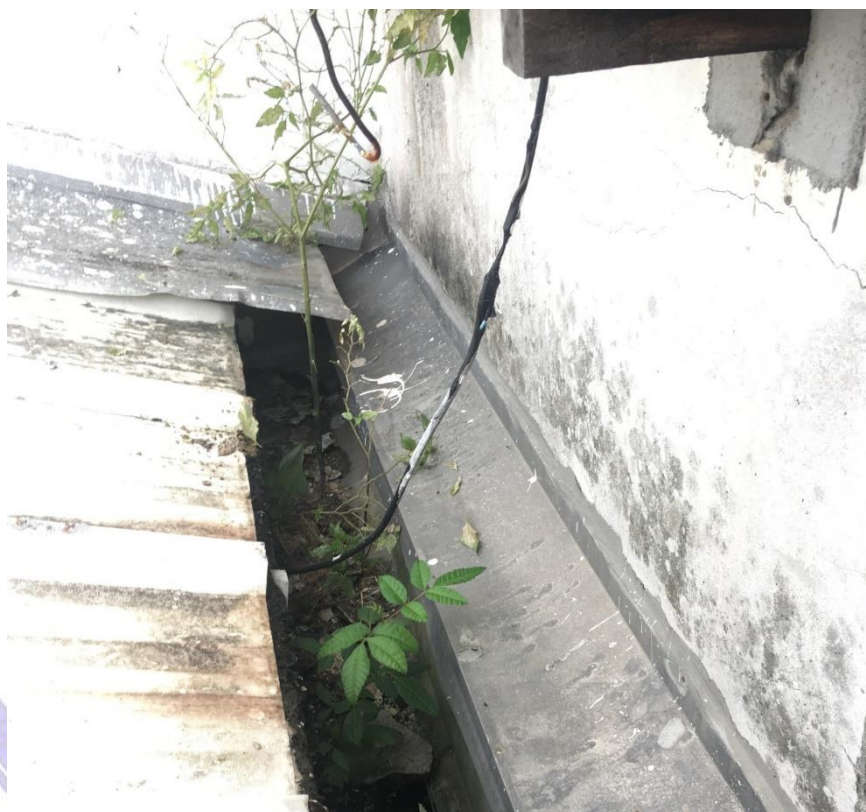
Figura 13: Deve ser realizada a limpeza adequada e periódica das calhas.
