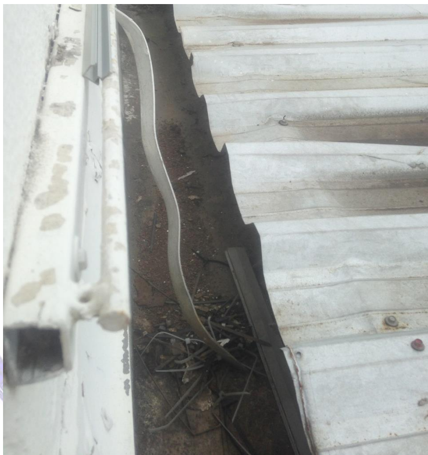
Figura 29: Telha com pingadeira insuficiente, facilitando o retorno da água pela telha.
