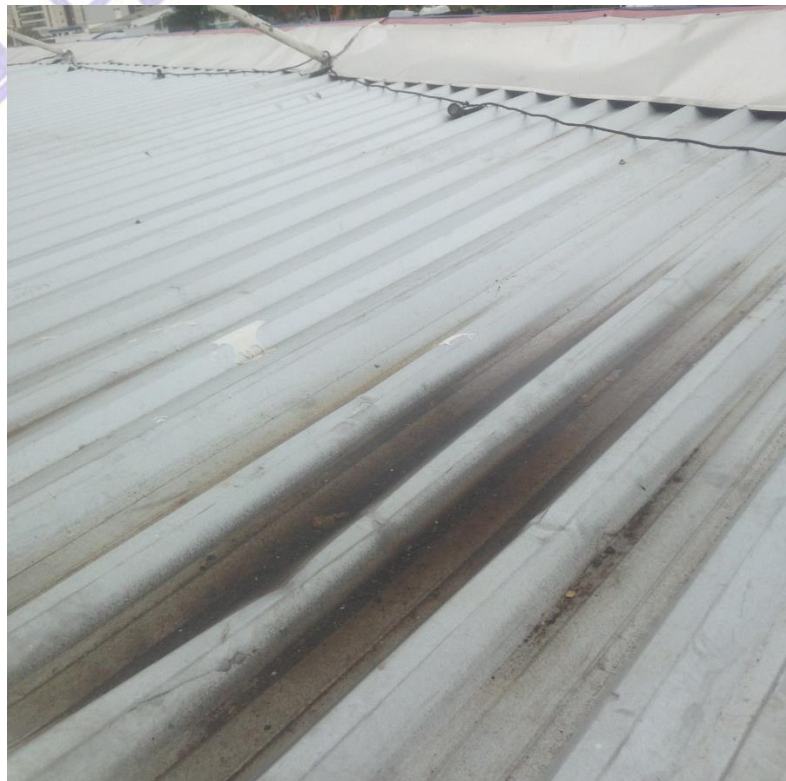
Figura 33: Rufos cobertura da fachada frontal, devido ao acúmulo de água e recorte irregular, facilitam o retorno de água por suas fresas.
