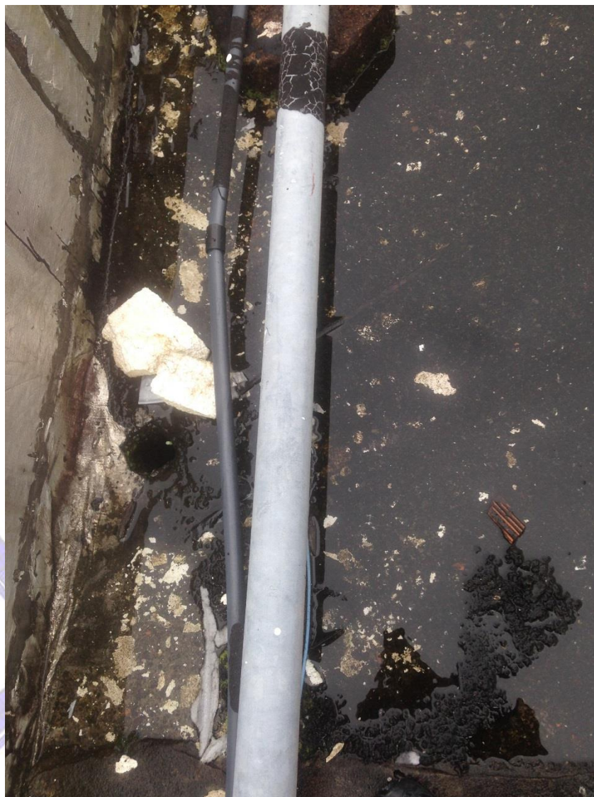
Figura 49: Falta de proteção mecânica na manta e sem aplicação adequada, aumentam a infiltração de água e diminuem a vida útil.
