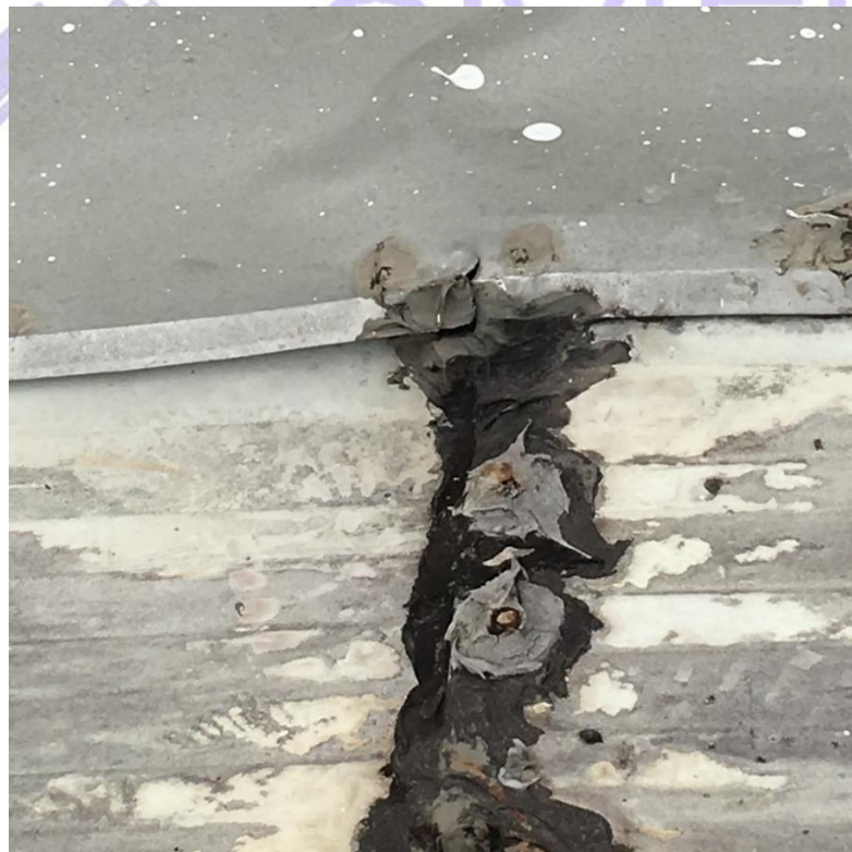
Figura 12: Reparos antigos que não estancam a infiltração de água nos pontos.
