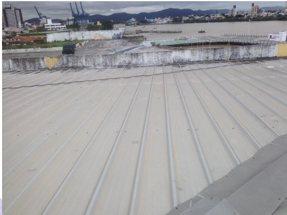
Figura 20: Cumeeiras sem recorte adequado.
