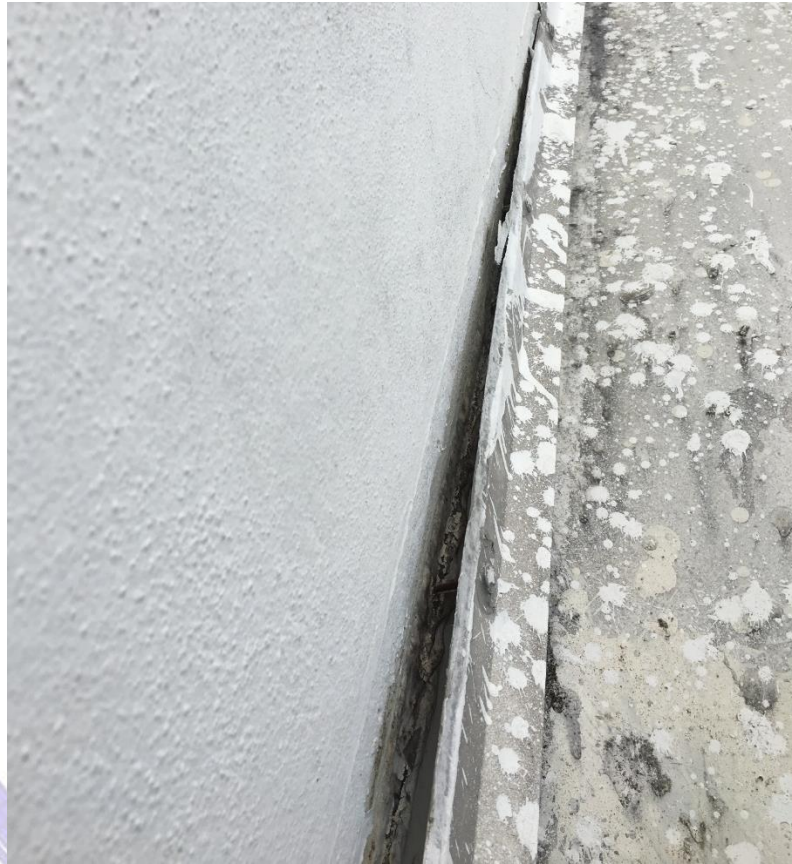
Figura 32: Rufos do telhado do pavilhão principal, já descolando o PU.
