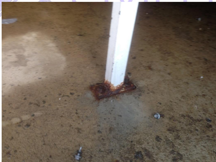
Figura 25: Estrutura metálica em estado de deterioração onde há acúmulo de água. Muitos parafusos, madeiras e outros materiais abandonados abaixo do telhado.
